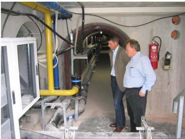
Abb. 2: Begebarkeit eines begehbaren Leitungsganges
