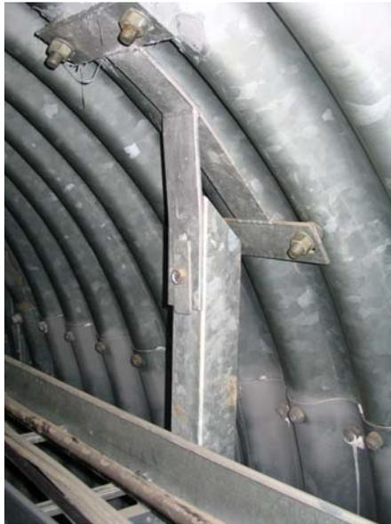
*Abb.5: Stahlverbindung einzelner Stahlwellblechplatten*
