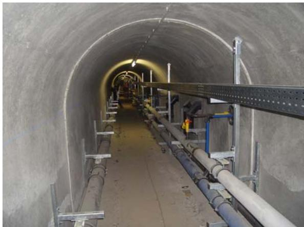
Abb. 17: Anordnung der Leitungen im begehbaren Leitungsgang
