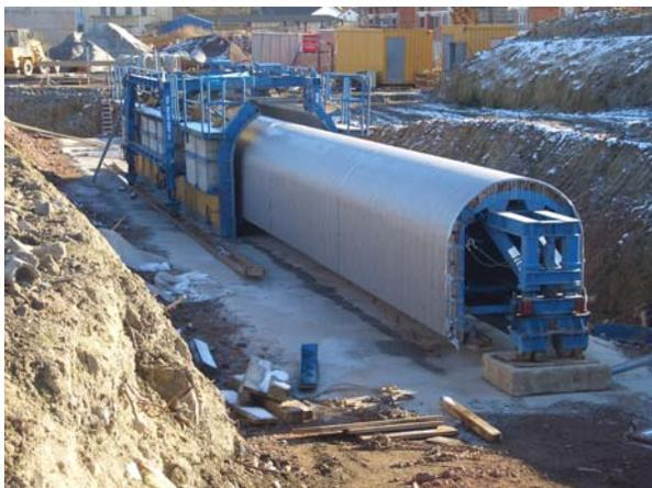
Abb. 15: Schalungsvorgang mittels Schalungsmaschine
