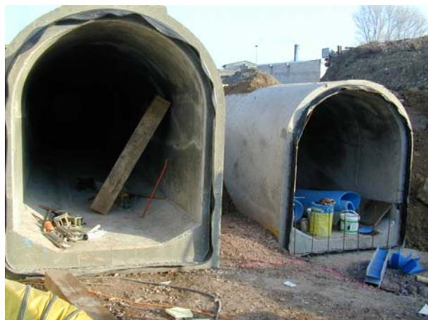
Abb. 4: Tunnelform des monolithischen Faserbetontunnels
