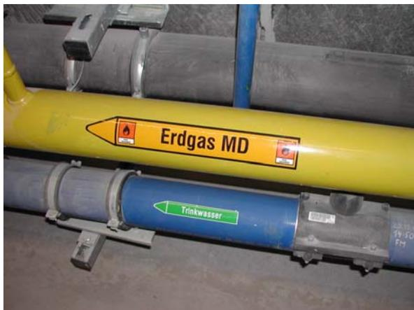
Abb. 19: Erdgasleitung, verlegt im begehbaren Leitungsgang
