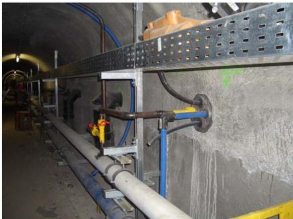
Abb. 18: Ver- und Entsorgungsleitungen im begehbaren Leitungsgang
