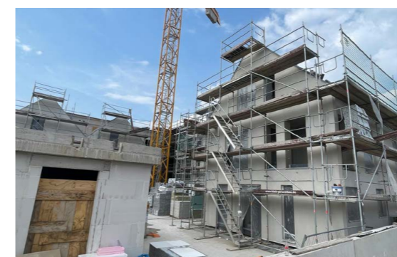
Der Rohbau steht, im April 2025 soll das Gebäude fertig sein
